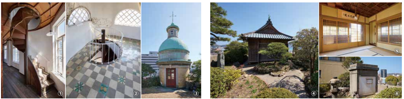
①屋上へ上がる木製の螺旋(らせん)階段。宮大工だった棟梁が手がけた。②タイル張りの塔屋内の床。③塔屋の上に明かりを灯し、自社船が関門海峡を航行する際の目印とした。④陸屋根に土を敷き、松などを植えて造った庭園と離れ座敷。⑤半間の床が付いた離れ座敷。⑥滑車を使った手動式エレベーター。来客の食事を階下から運んだ。
