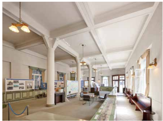
1階事務所は洋風の造作。梁と4本の独立柱はC・I形鋼と鉄筋コンクリートで造られている。柱の持ち送りは、上の鉄骨を支える部材を装飾的にしたもの。
