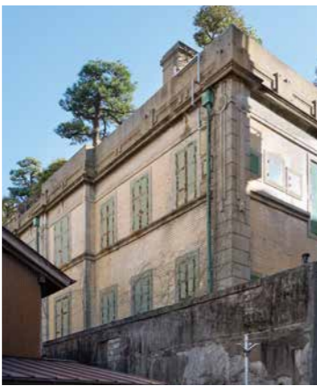
敷地東側に防火壁、2・3階の窓に防火扉を備えていたために太平洋戦争時、類焼を免れた。
