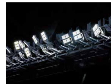
グレアを抑えるため1台ごとに照射方向が変えられた 1kW・2kW相当のLED投光器
