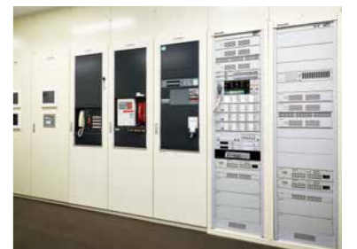
防災センターに設置された、空調・防災・非常放送など、各種ビルシステムの自立盤
