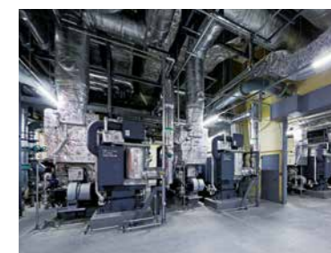
球場全体の冷暖房を担う4台の ナチュラルチラー（吸収式冷凍機）
