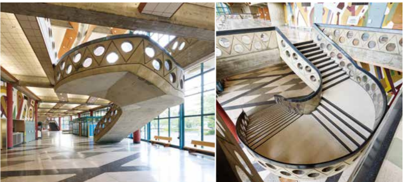
ロビーと2階を結ぶ階段は踊り場の下に支柱を必要としない設計で造られた。折板の直線的な表情に対して、階段は曲線的なデザイン。らせんを描くように延び、手すり周りを円形、三角形などの幾何学模様が彩る。
