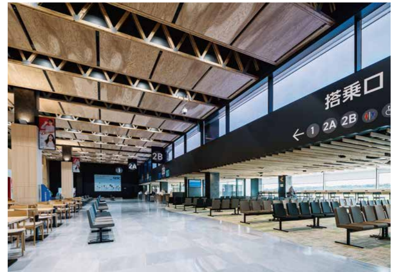
2層吹き抜けの出発階には木トラス天井に地元の熊本県産小国杉を使用。低天井の待合スペースはグレアレスシーリングライトにより光源の存在を抑えている
