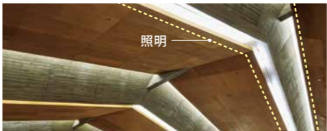
照明 ホール天井。合板の裏に設置した間接照明が折板を照らしている。ここにも転倒防止の引張材の一部が見えている。
