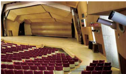
ホール内の折板壁は内側に約12.6度傾いている。両壁側の階段は途切れることなく花道のように舞台へと続いていく。
