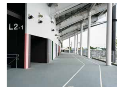
1周約570mのランニング・ウォーキングコースの壁面に設けられたスポットライト
