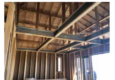
瓦屋根を支え、強風にも対応するテクノビーム(工事中写真)
