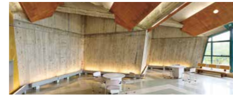
2階ホワイエ。外観で目を引くコンクリート打ちっ放しの折板壁は館内でもその蛇腹状の形を見ることができる。
