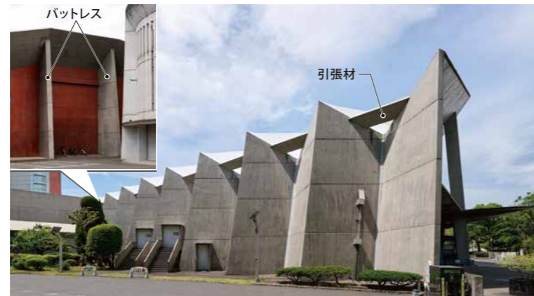
屋根を貫く引張材が見える。壁と屋根が描く各アーチは同一平面上になく前方(写真右)に傾斜しているため、舞台側に引っ張り、転倒を防止。舞台側末端は建物後面のバットレスに定着させている。
