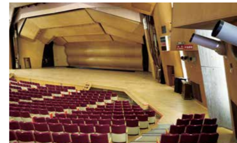
ホール内の折板壁は内側に約12.6度傾いている。両壁側の階段は途切れることなく花道のように舞台へと続いていく。
