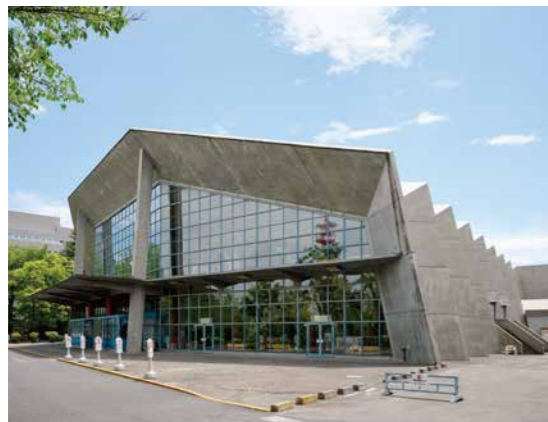
蛇腹状の折板と約60mの大開口がダイナミックな外観。剛性に優れた折板構造の特性を生かした屋根は厚さわずか約12cm、壁は約25cm。
