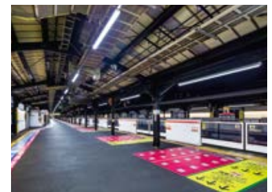
8フィートの特注ホーム用LEDベースライト(右列)が線路とホーム間を照らして視認性を確保
