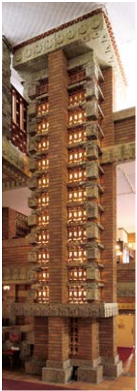
「光の籠柱」。透かし彫りから照明の光がもれる。メンテナンスの際は、つるべのように紐を引き開口部まで照明器具を移動させる仕組み。
