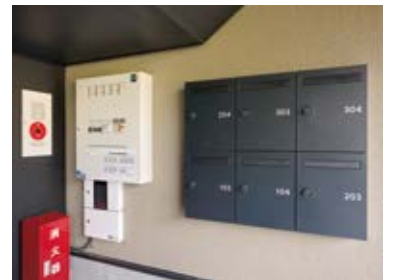
住宅棟の集合住宅用サインポストと 火災報知器、P型1級複合受信機(自動試験機能付)
