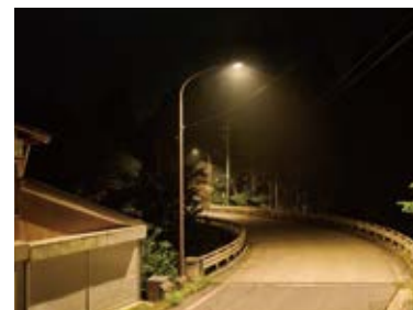
生活に必要な明るさを確保しながら光害を抑えるDarkSky認証器具に置き換えられた道路灯
