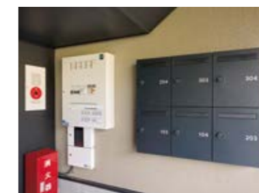
住宅棟の集合住宅用サインポストと火災報知器、P型1級複合受信機(自動試験機能付)
