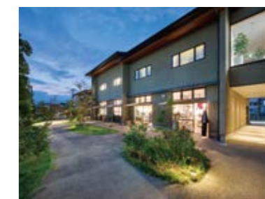
優しく景観を照らすLEDフットスタンドライト。2階はノースオブジェクトの本社事務所が入居
