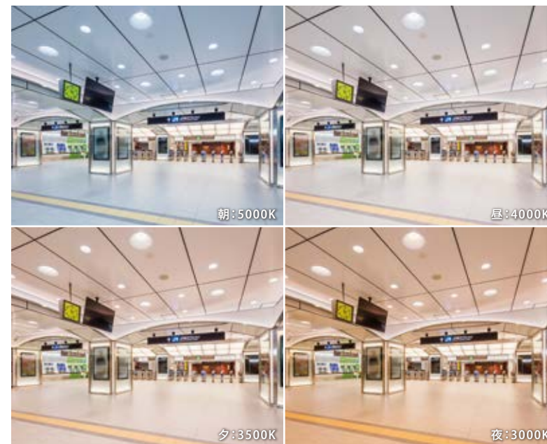
水面をイメージして、まぶしさを抑えたSmartArchi ソフトライトの調光調色タイプをランダムに配置し、水都大阪に架かる橋をモチーフとした建築意匠も併せて自動照明演出しているコンコース
