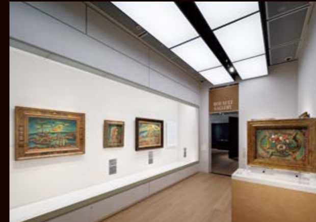
世界で唯一ルオーの名前を冠した展示室「ルオー・ギャラリー」。特許技術の反射板で配光制御された均斉度の高い展示ケース(左)と開閉式でメンテナンスが容易になった特注光天井照明器具
