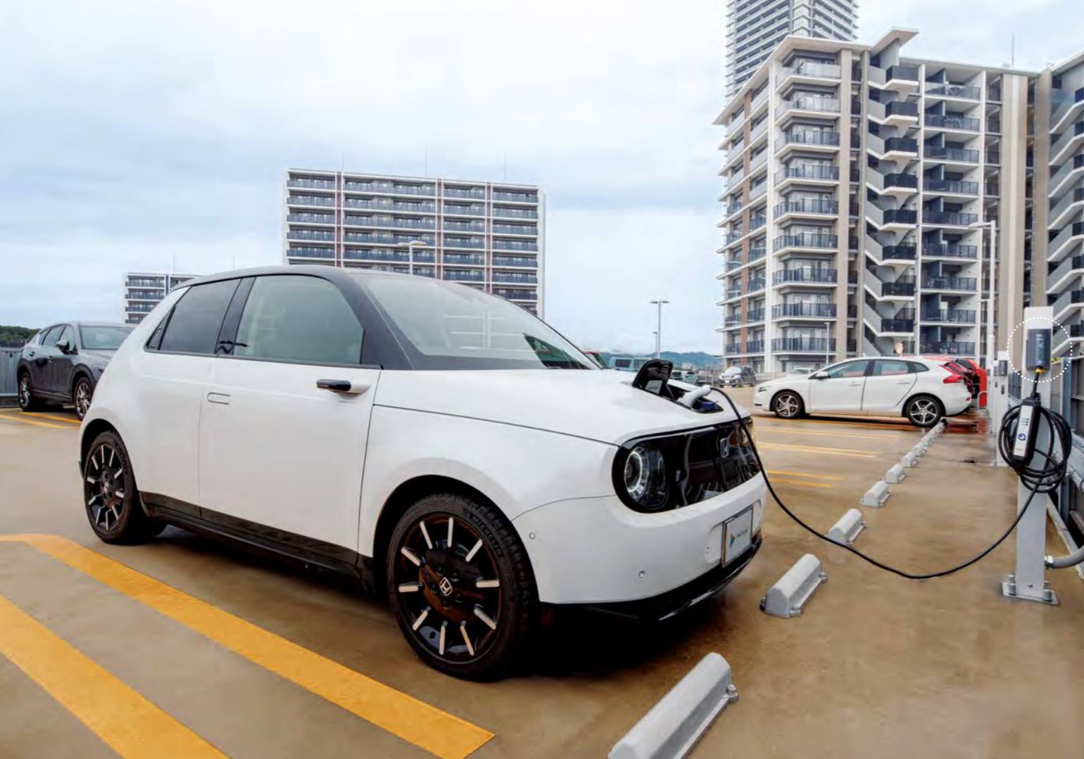
マンション駐車棟の全429区画に設置された、個別に基礎充電できるEV充電用3kWコンセント
