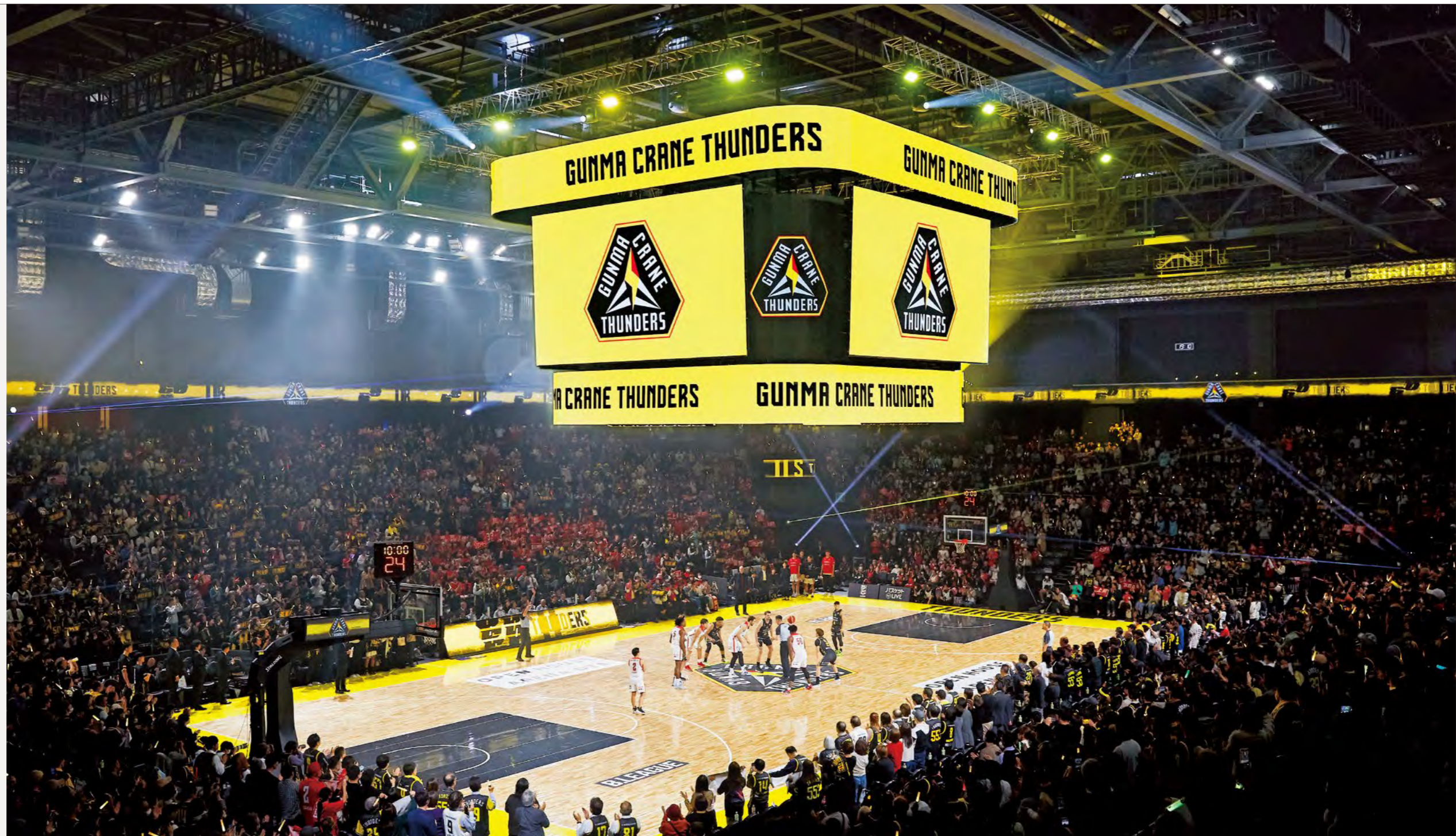
床面積約2,100㎡のメインアリーナでは、FIBA認証を受けたパナソニックのLED投光器「スタジアムビーム」やLEDムービングライトによる劇場型照明が配置され、臨場感と一体感のある環境が創り出される。客席は収納式で写真はバスケットモード。配光もセンターコートに絞られている
