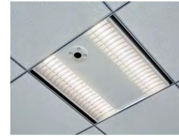
設備プレートに設置された空間環境センサは人の微細な動きや在/不在も検知し制御可能
