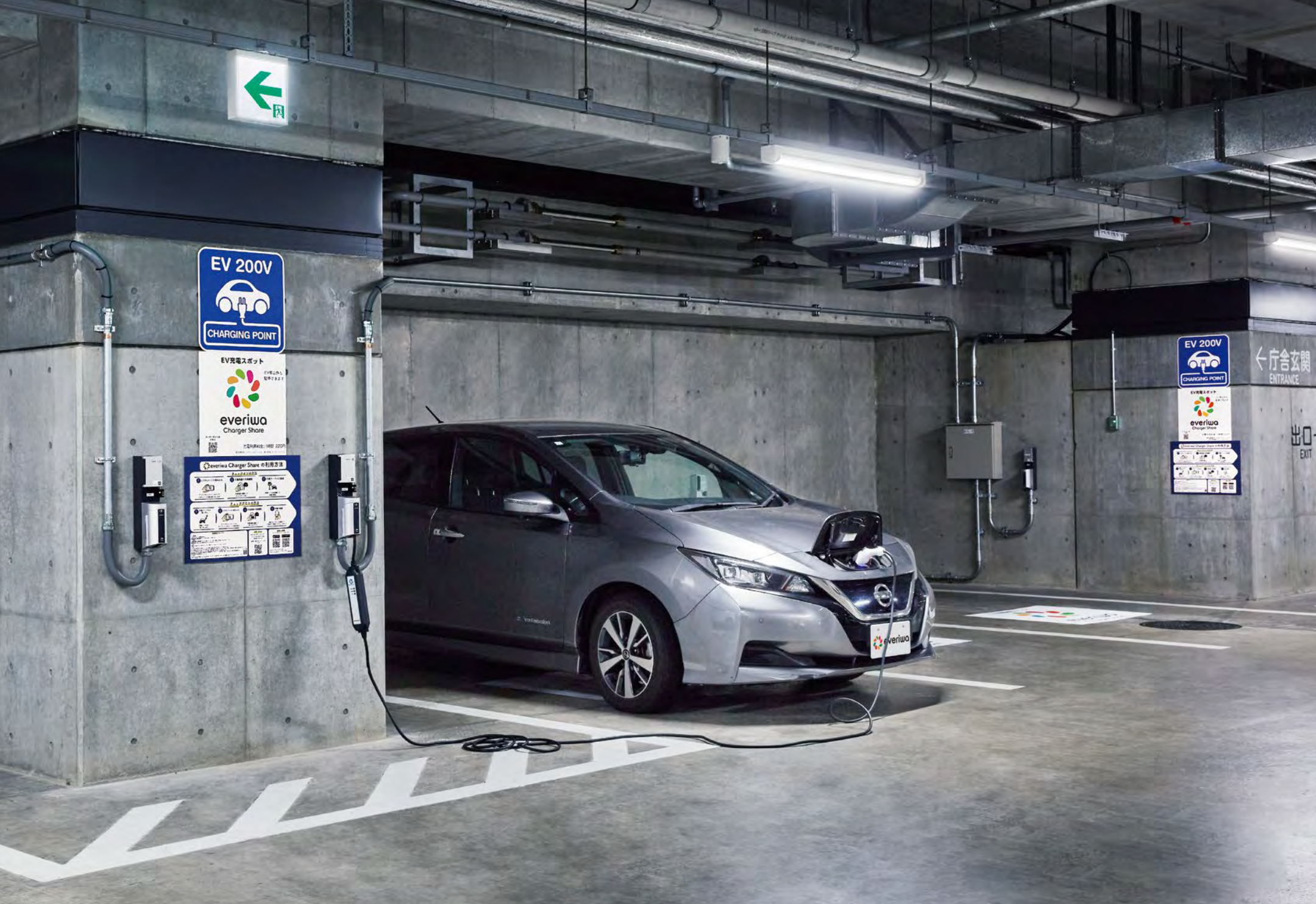
市川市役所第1庁舎に設置された「everiwa Charger Share」のEV充電用コンセント
