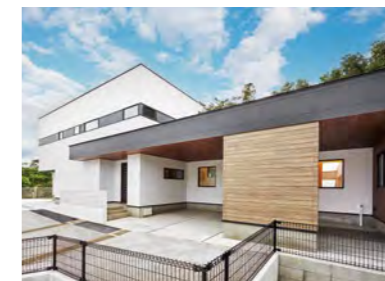
耐風を考慮した上で大開口を実現したE号地のガレージ
