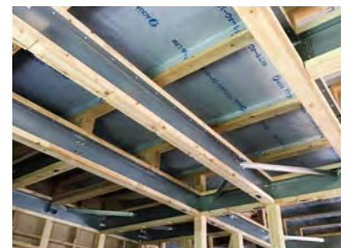
木の梁を軽量H形鋼で補強する「テクノビーム」は台風や地震など一時的にかかる大きな力に強い
