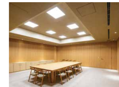
折り上げ天井にベースライトが設置された議会応接室
