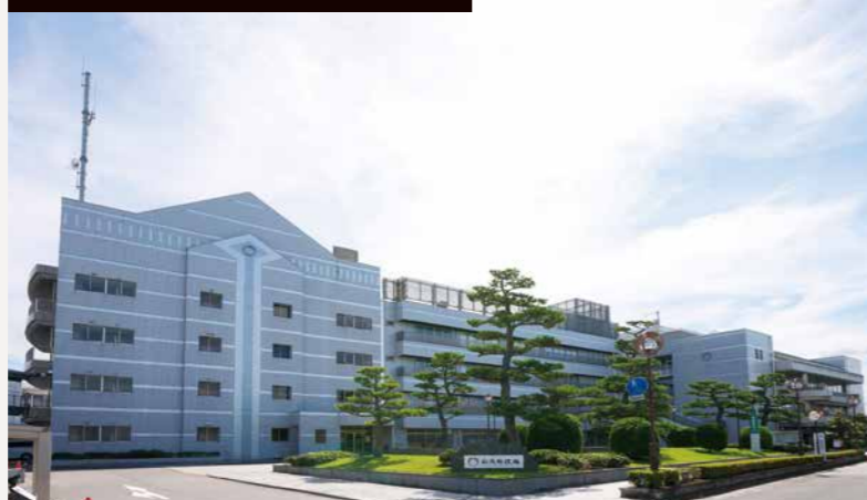
1.太陽電池モジュール（9.12kW）、2.産業用蓄電池（15kWh）を2016年に設置
