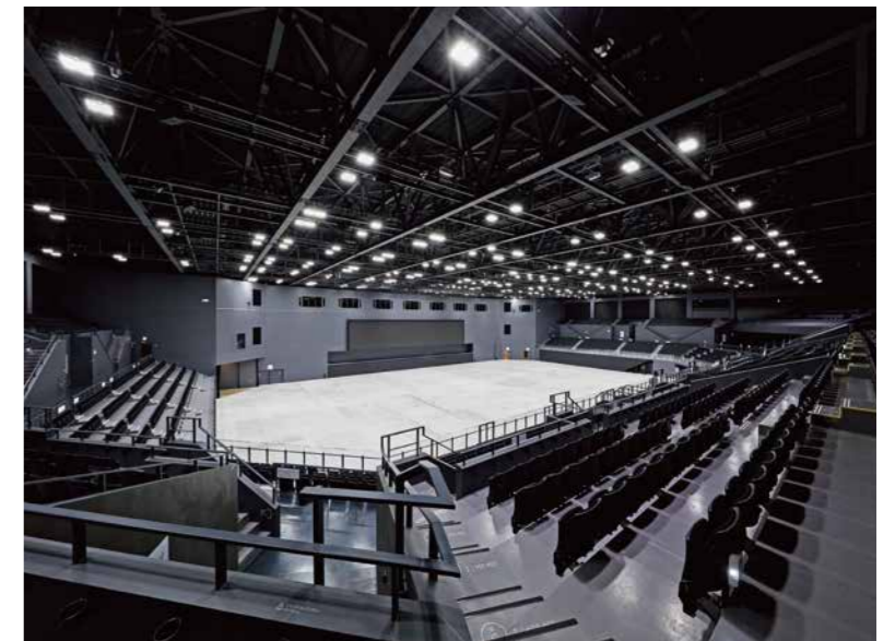
国際大会の設計基準を満たすLED高天井用照明器具が採用されたメインアリーナ
