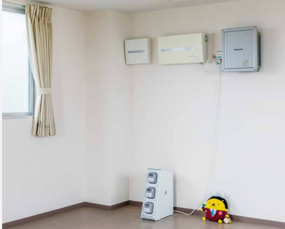
地上高が約6.4mあり、地域住民35名が避難できる。停電時には太陽光発電システムの自立運転で「イーブロック」を充電し、災害時には地域住民のスマートフォンの電源となる（設置：2023年度）
