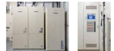
2~4階に設けられたパワーステーションダブル(11kW×3台)と産業用蓄電池(5.6kWh×6台)
