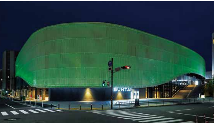
(上)外装アルミ板の背後に設置したライトアップ演出用照明器具「アーキライン」が建物を彩る (下左から)緑色、赤色、国旗「日の丸」をイメージしたライトアップ演出の変化
