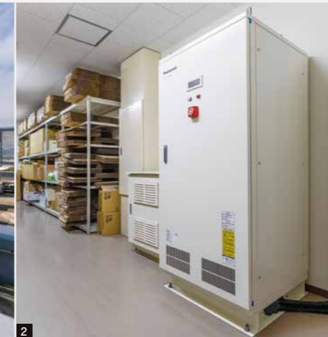
災害時における職員の通信用と、避難住民のスマートフォン充電用に事務室に「イーブロック」を設置。「イーブロックステーション」なら差し込むだけで充電管理ができるので、職員の手間が省ける（設置：2023年度）
