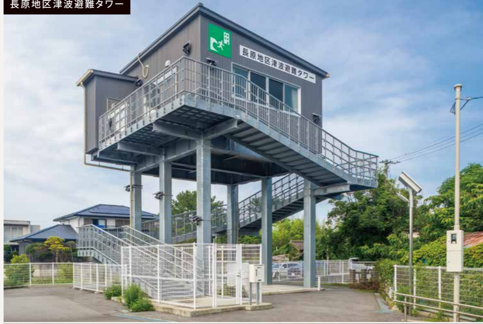
長原地区津波避難タワー
