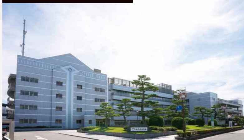
1.太陽電池モジュール（9.12kW）、2.産業用蓄電池（15kWh）を2016年に設置
