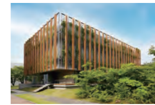
戸田建設株式会社 筑波技術研究所 グリーンオフィス棟
