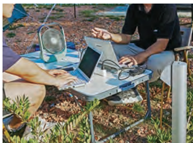
DポールからAC100Vを給電するので、 テーブルタップにより複数のPCや扇風機も利用可能
