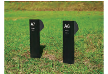
電源コンセントの裏面を施工者が区画表示として加工
