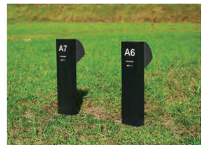
電源コンセントの裏面を施工者が区画表示として加工
