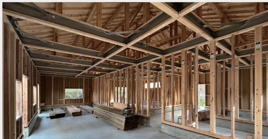
重い瓦を支える、木と鉄の複合梁を用いたテクノストラクチャー工法（建築中の事務所棟）
