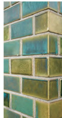
黄色がかった緑色など、窯変が美しいタイルは手仕事で貼られた。
