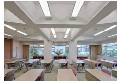
4階集会室。反り上がった庇を支える梁にも角度がついている。2000年の改修時に梁型を見せる仕上げになった。
