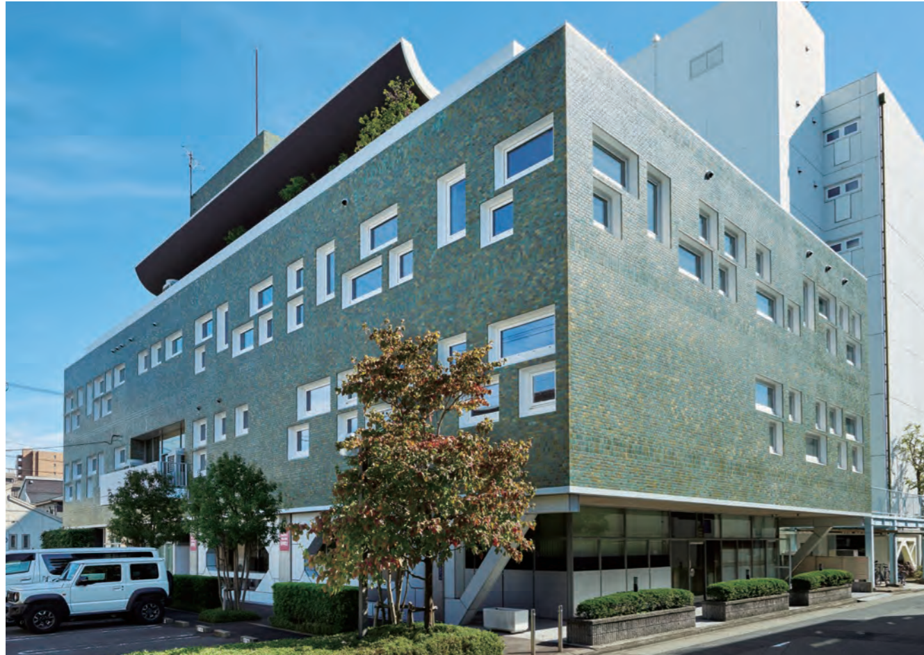
建物が地面から浮いたように見える中産連ビル本館。小窓の形状・配置がユニーク。織部色と呼ばれる緑色のタイルは見本焼きを何度も繰り返して作った。
