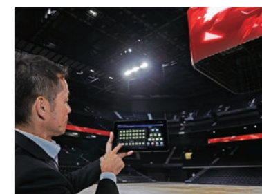
照明パターンを現場で調整できる操作タブレット
