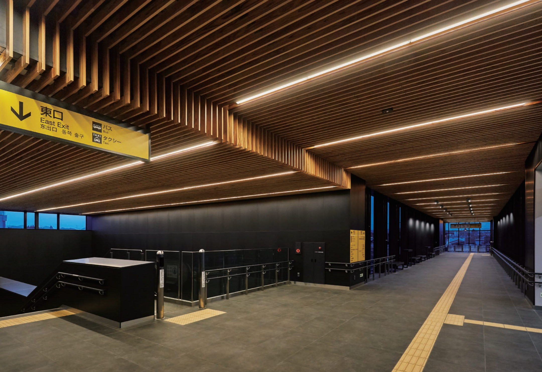
右側に駅改札口がある東口2階から東西自由連絡通路を経て西口方向を望む。天井は県産材のルーバーで構成され、その間に無線調光システムにより調光が可能な一体型LEDベースライト「sBシリーズ」が配置されている
