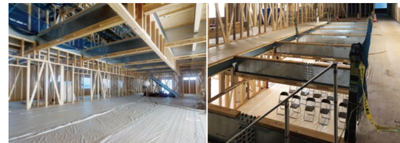
テクノビームが接合されている上棟時の吹き抜け大ホール
