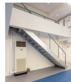
階段はテクノビームの梁の金属部分に接合
