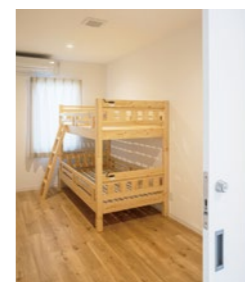
車いすでも通れる間口80cmの引戸を設置した静養室
