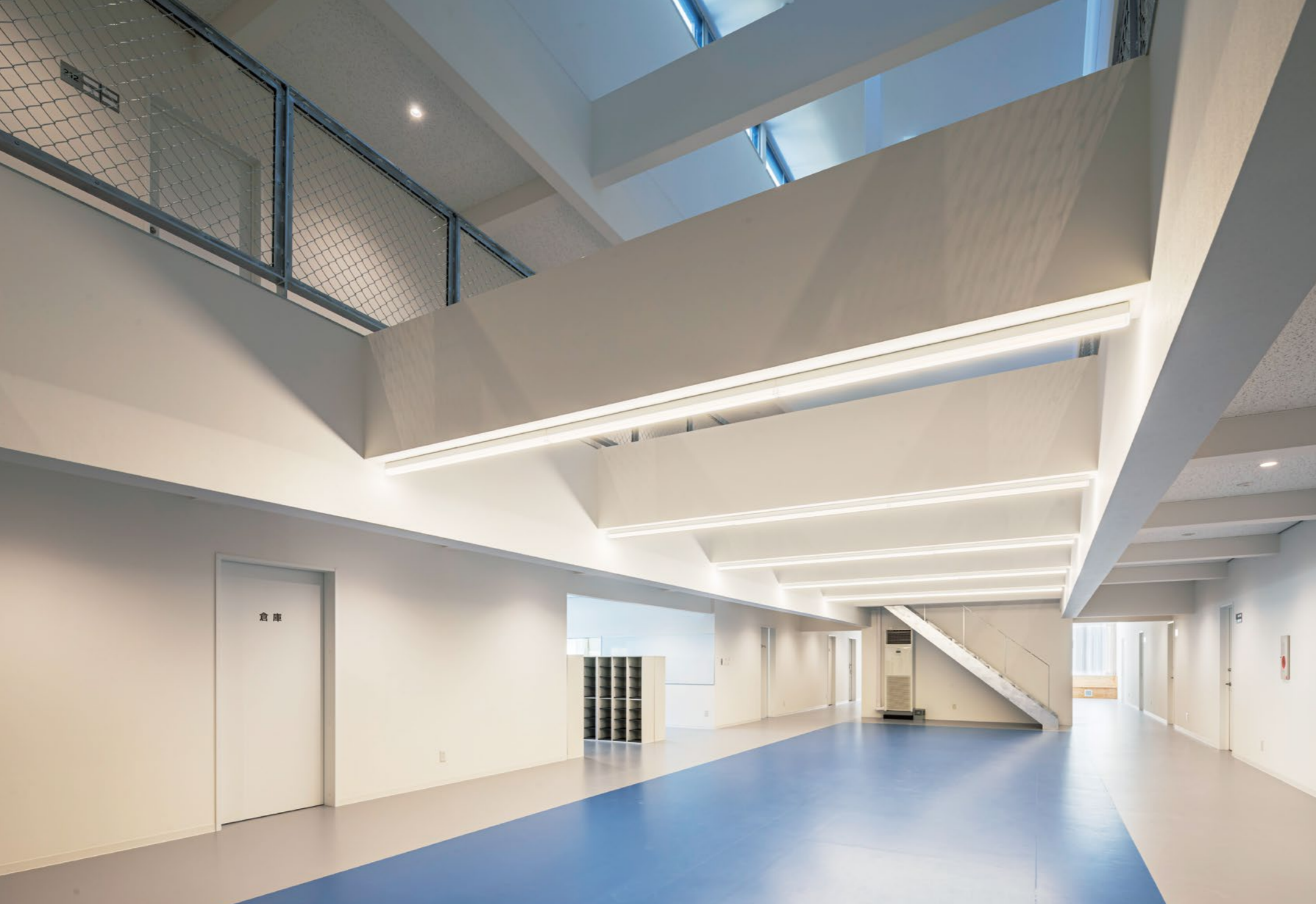
テクノストラクチャー工法により実現した全寮生100人が集える16,550mm×7,640mmの吹き抜け大ホール。トップライトから差し込む光が吹き抜け大ホールの開放感を高めている
