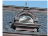
大屋根のドーマー。換気用で中に部屋はない。
