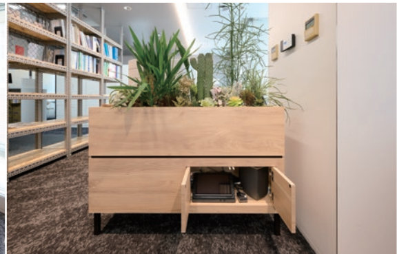
窓側の集中ゾーン「プラクティス」。プランターボックスの柱側にスピーカー開口部があり、環境音が柱に反響してゾーンを包み、外からの音をマスキングする【日建設計コンストラクション・マネジメント 大阪オフィス】
