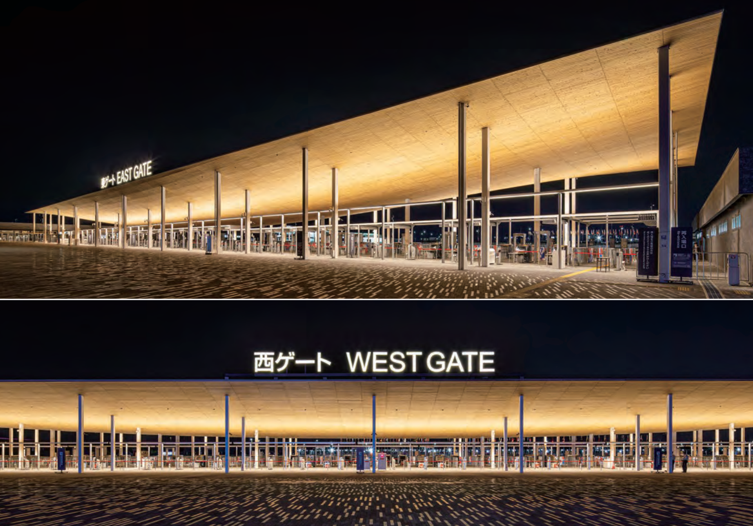
(上)全長約119mの東ゲートと(下)全長約150mの西ゲートでは船底天井の傾斜も異なっているが、外観イメージは共通になるよう配慮されている
