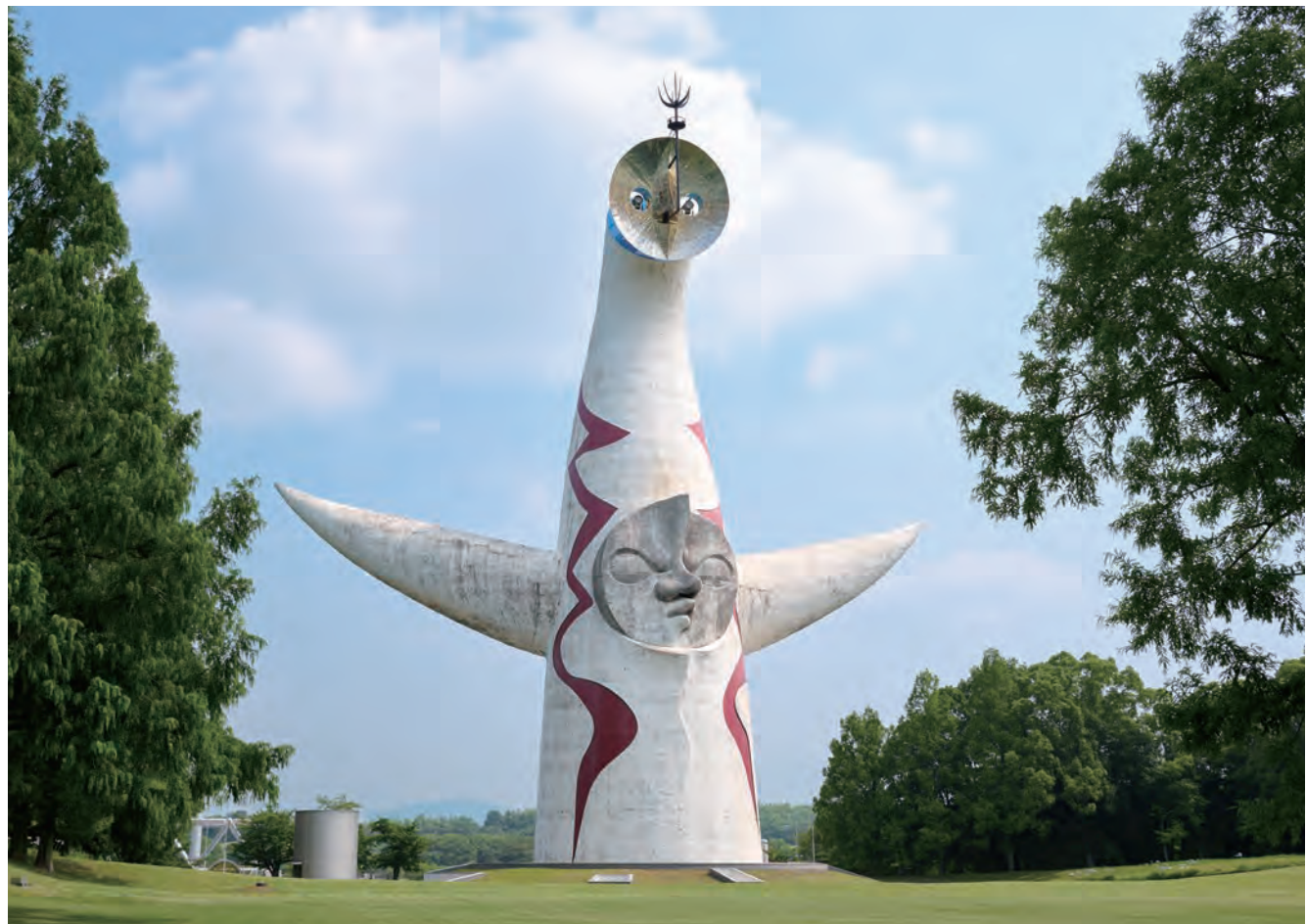
高さ約70m。屋外に設置された太陽の塔は、その巨大で独特な姿をさまざまな場所から見る事ができる。 1992年度改修工事では黄金の顔を交換、2016年度改修工事では軽量化のために塔内のエスカレーターを階段に変更、胴体下部のコンクリート打ち増しなどを行った。
