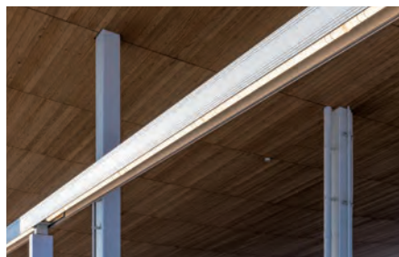
上下にLEDライン照明が組み込まれたH型アーム
