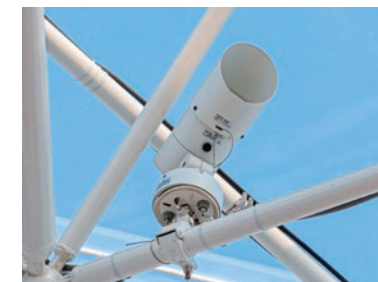
膜屋根のフレームに取り付けられたDMXスポットライト
