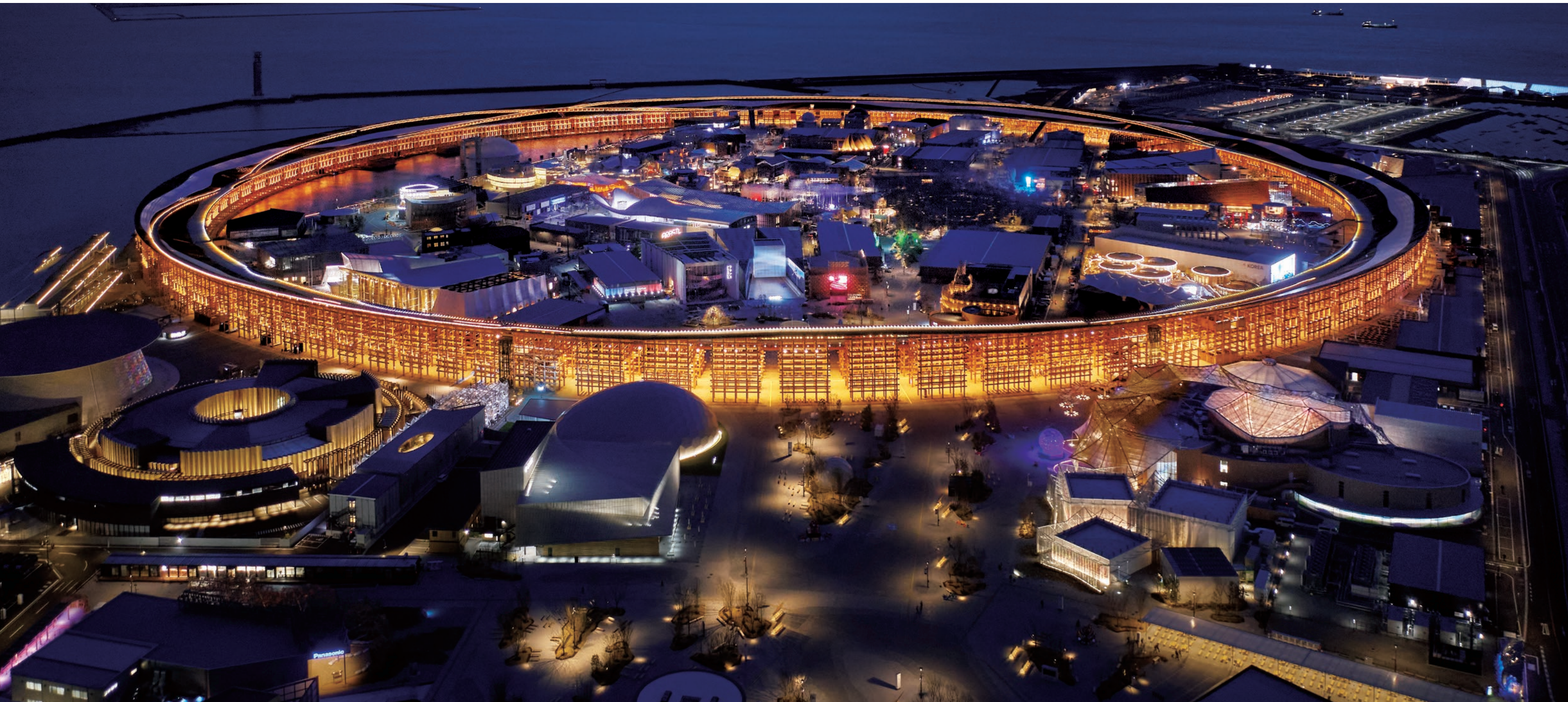
外径約675m、幅約30m、高さ約12m（外側約20m）の大屋根リングを北東上空から望む。 照明ガイドラインによって上空への光漏れや光害を抑えるように設計されている
