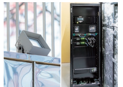
ライトアップ用投光器「ダイナワン」(左)と各種設備を制御する、「コントローラAREAS」(右)
