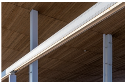
上下にLEDライン照明が組み込まれたH型アーム
