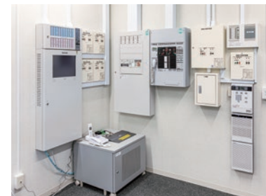
集約された中央監視盤(左) 自火報設備(中央) 非常放送設備(右)
