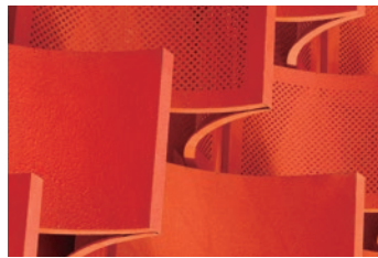
反響板。円柱の塔内でおこるハウリングや多重反響を制御するために設置。
