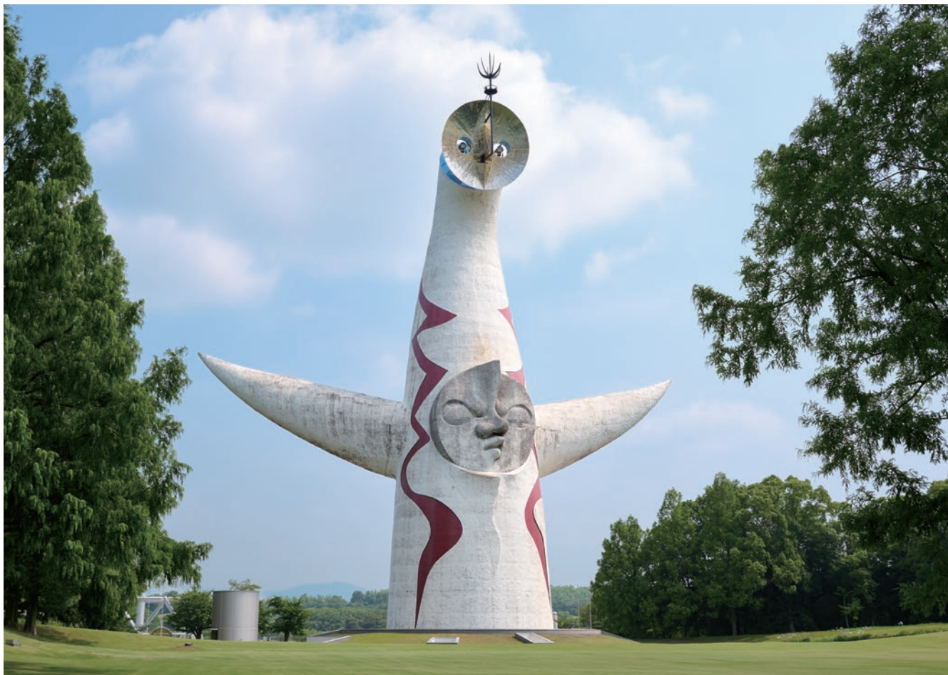
高さ約70m。屋外に設置された太陽の塔は、その巨大で独特な姿をさまざまな場所から見るができる。 1992年度改修工事では黄金の顔を交換、2016年度改修工事では軽量化のために塔内のエスカレーターを階段に変更、胴体下部のコンクリート打ち増しなどを行った。
