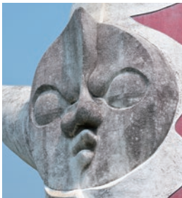
太陽の顔。直径約12m。FRPの下地に発泡ウレタン、コンクリート吹き付け、樹脂塗装を施して造った。
