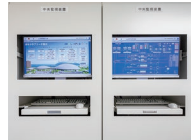
アリーナ全体の設備を監視制御する 統合監視システム「ESU-BA」
