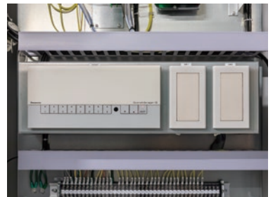
メインアリーナの放送席に設置された 小型記憶調光システム「シーンマネージャーG」
