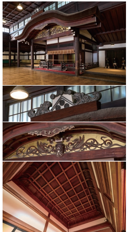
玉座は前の間、玉座の間、控えの間で構成。ここにも亀岡式の装飾がある。玉座の間は折り上げ小格天井。
