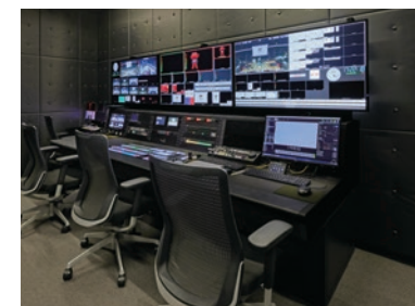
アリーナ内の照明・映像・音響設備・サイネージを一括制御できる総合演出システム「KAIROS」
