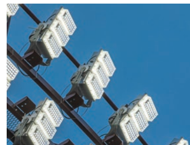
グレア抑制や照度分布図などシミュレーションを重ね、1台ごとに角度調整されたLED投光器
