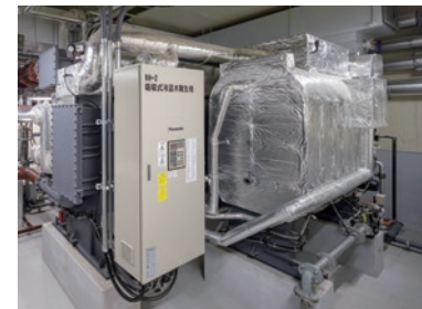
サブアリーナの機械室に設置された 吸収式冷温水機
