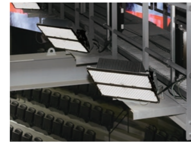
FIBA ※2 認証を取得した業界唯一の照明器具である「グラウンドビームER」を競技用に112台設置
