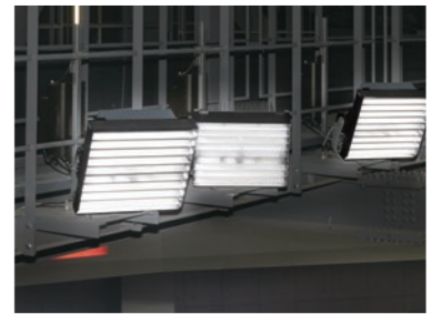
グレア（まぶしさ）を低減するために一部照明器具にルーバーを設置
