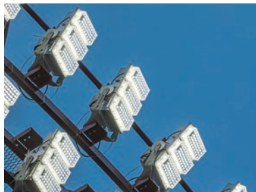
グレア抑制や照度分布図などシミュレーションを重ね、 1台ごとに角度調整されたLED投光器
