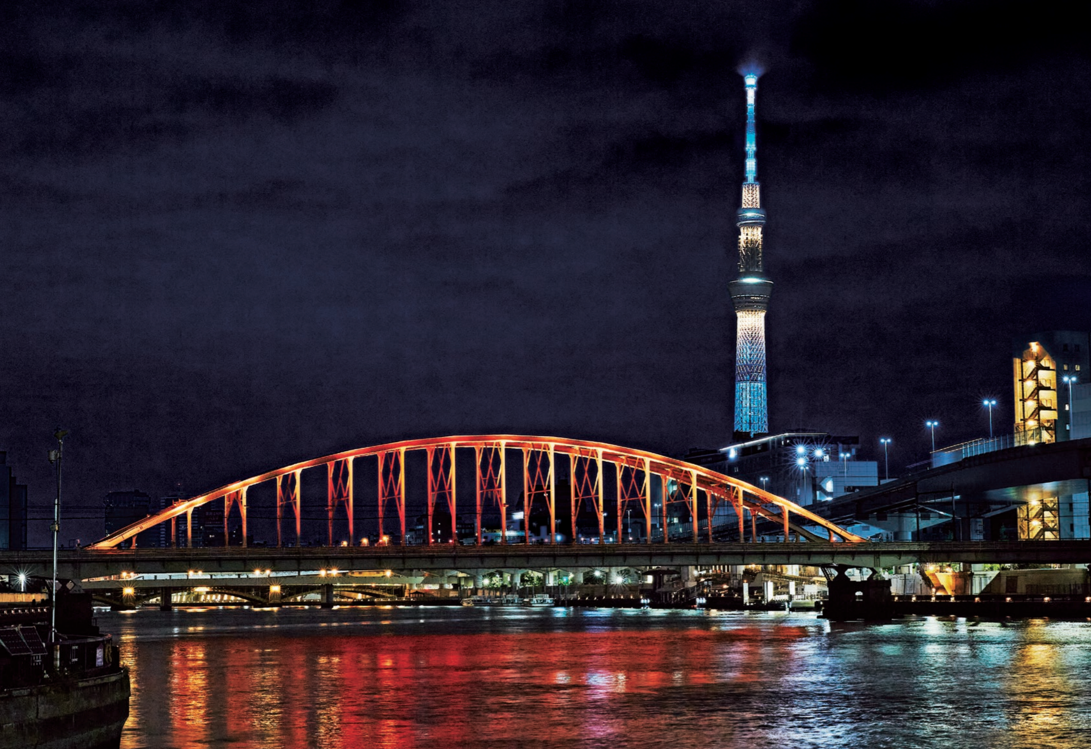
浅草橋駅・両国駅周辺を訪れる人や隅田川テラスや観光船を利用する人たちを魅了するJR総武本線隅田川橋梁ライトアップ。アーチ端部、支柱下部にカラー演出投光器を設置してプログラムにより点灯・揺らぎ・流れなどを演出している。写真は優しい電球色の揺らぎが寄り添い、まちに溶け込む通常演出
