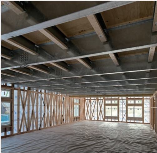
木の梁に鉄を組み合わせ強度を高めた複合梁「テクノビーム」
