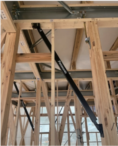
地震の揺れを吸収する制震システム「テクノダンパー」 繰り返される揺れへの効力が期待できる
