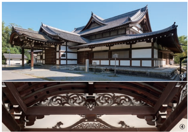
③ 玉座の背後にあたる位置に檜皮葺き、唐破風屋根の車寄せが増築された。 ④ 車寄せには西洋絵画の影響を受けたと言われる亀岡式の装飾がみられる。
