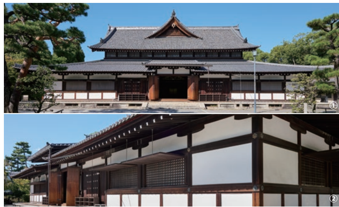
① 千鳥破風を頂く桧瓦葺き主屋根と緩やかに延びる裳階が大寺院を思わせる外観。 ② 舟肘木や角柱を用いた外壁に見られる半部。上半分を外側へ吊り上げて開く。
