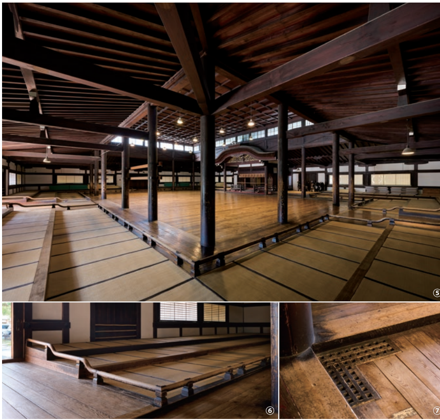
⑤ 板の間の四周を観覧席が取り囲み、スタジアムのような構成になっている。柔道などで使用する際は板の間に畳を敷き詰める。⑥ 観客席には高欄を回す。廊下側は登り高欄としている。⑦ 板の間の隅にある換気口。
