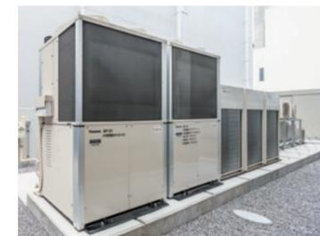
電力デマンド削減効果大きいGHP(35.5kW)2台を採用
