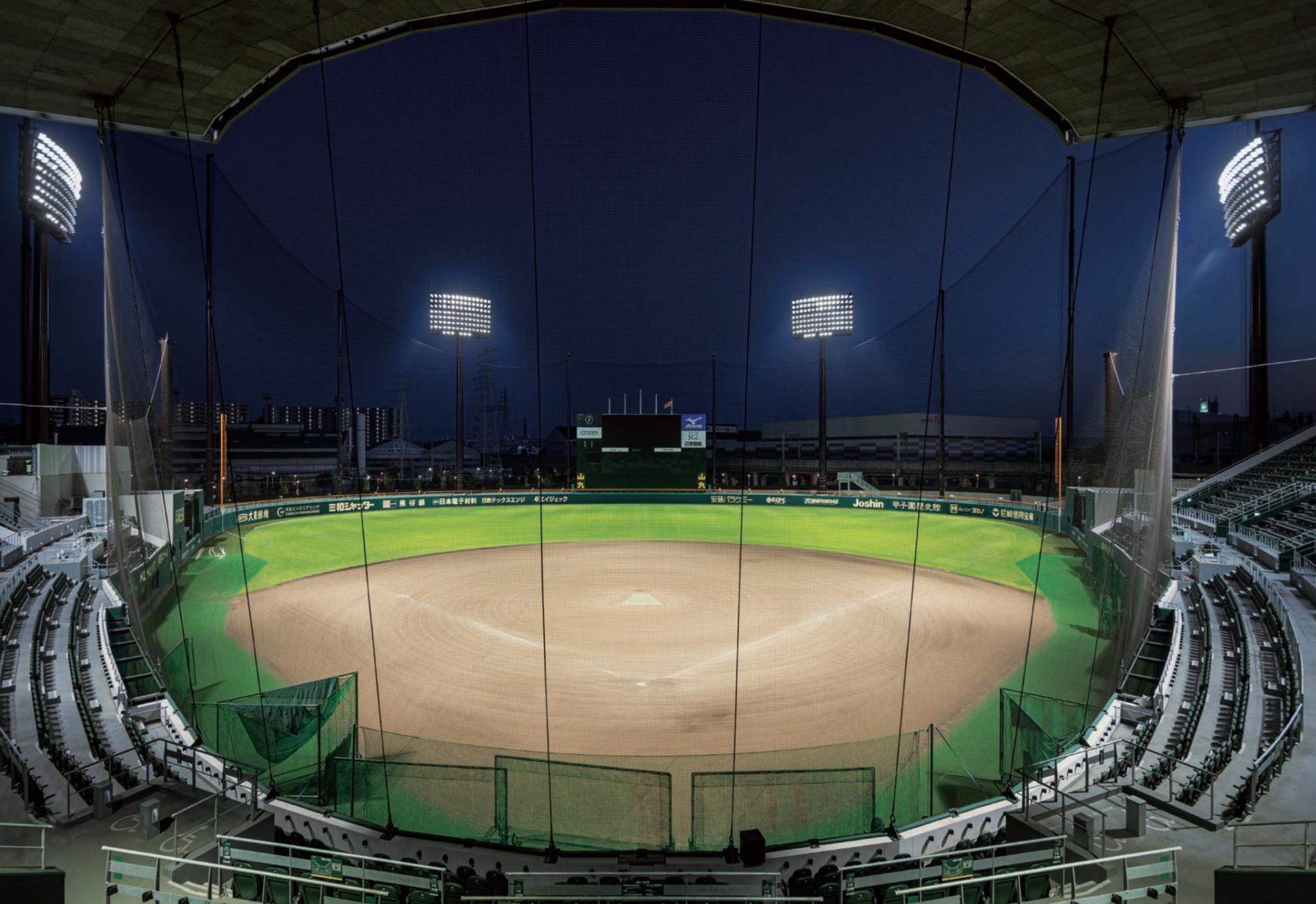
ナイター設備の計画にあたっては、隣接する鉄道の電車運転手や周辺の住宅への障害光調査を行い、VRIによる障害光確認のシミュレーションも実施。環境省の光害対策ガイドラインに適合するように照明計画を行い、6基ある照明塔によりスタジアム内をムラなく照明している
