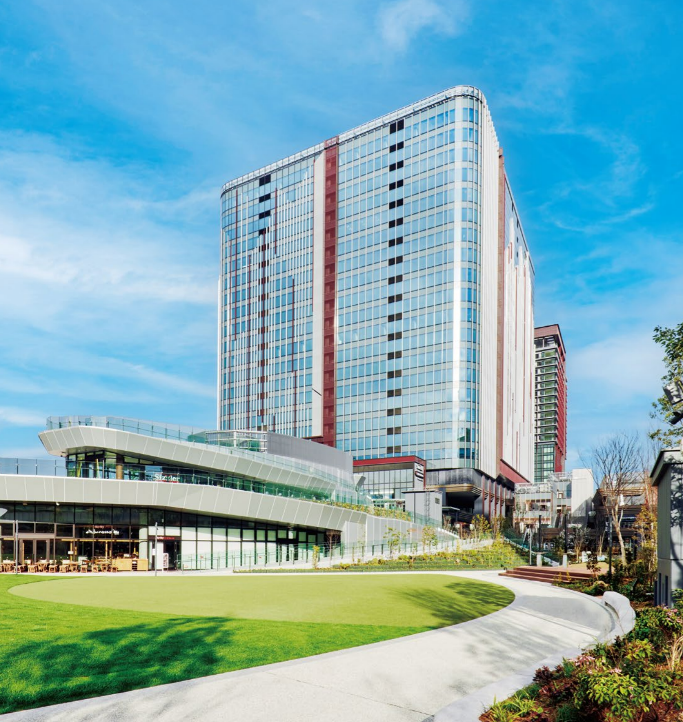
TRACKS PARKからBUSINESS TOWERと背後のHOTEL&RESIDENCE TOWERを望む。JR大井町駅トラックス口から続くTRACKS STREETは3階レベルでデッキとして接続し、計画中の品川区新庁舎(左側に建設中)を経て、しながわ中央公園に至る予定
