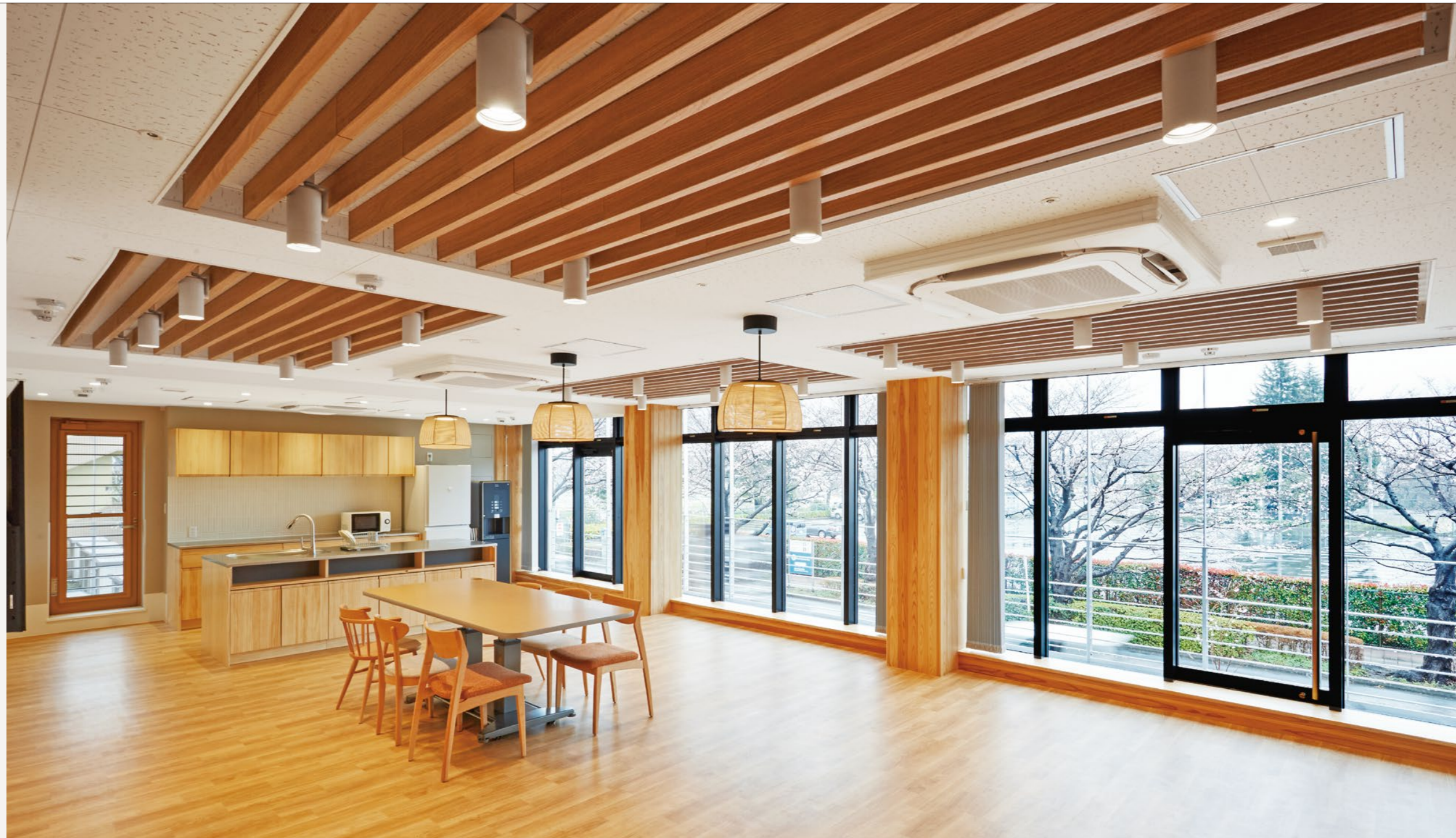
空間のあらゆる箇所に木質感があふれる2階のリビングルーム。天井には不燃軽量造作材「エアライトルーバー」を採用し、空間に個性を演出
