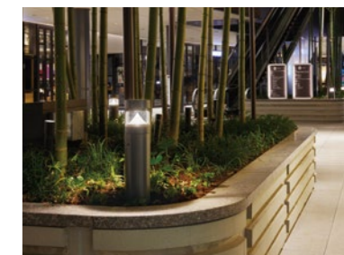
TRACKS STREETの植栽に設けられた庭園灯
