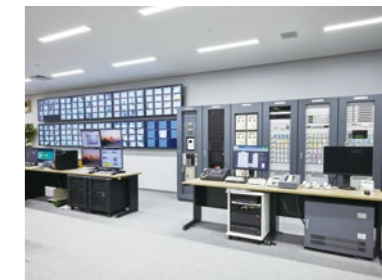
防災センターに設置された監視カメラシステム(左)と非常放送設備(右)
