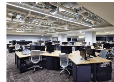
Bldg.C 固定席スペースはスケルトンとボードエリアで同形状特注照明器具を使い分ける構成
