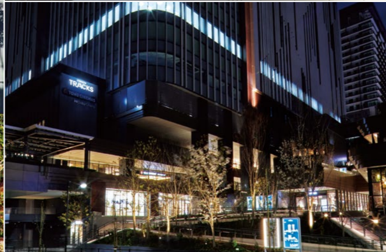
(上) CROSS PLAZA上部の大屋根 (中) TRACKS STREETの赤い柱に設けられたブラケット (下) ファサードに垂直に走るライトアップ
