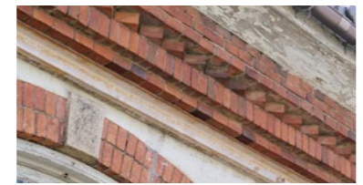
③ 軒下に施された装飾、ドクトゥース。レンガは幕末から明治期に取り入れられた建築材料の一つ。
