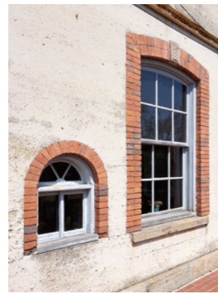
② 壁材の石灰コンクリートは、明治初期の限られた期間だけにしか使用例がない。
