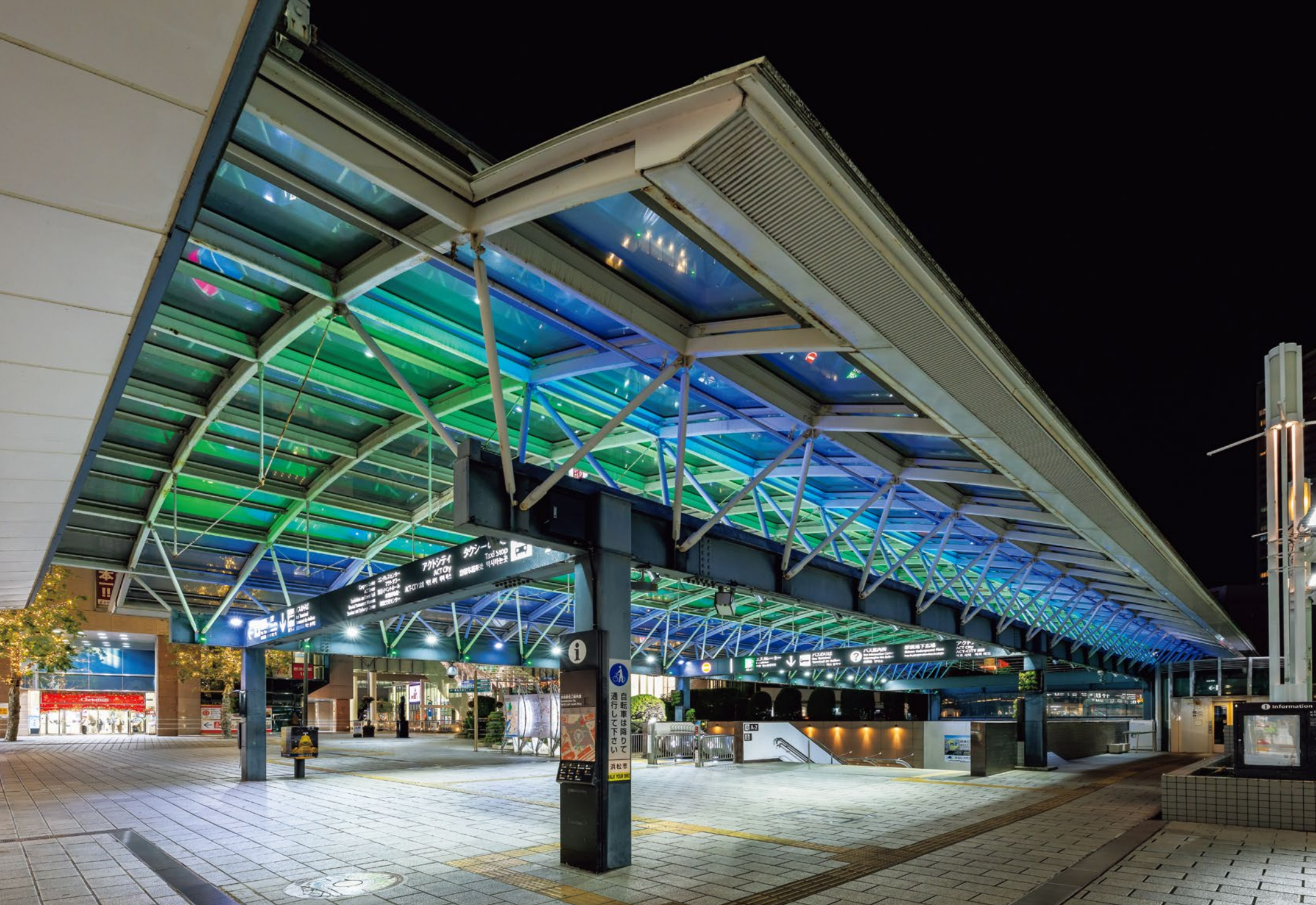
非常にスリムでコンパクトな「アーキライン」をアーケードのリブに組み込むことで、光源を見せることなくフルカラーライトアップされた歩行者通路。 演出は、浜松市を表すブルーとグリーンに塗り分けられたコラボカラー
