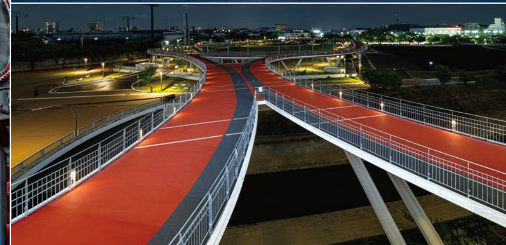
(上)名古屋市瑞穂公園内のパロマ瑞穂スタジアム (中)膜屋根と周囲の木格子を浮き上がらせるライトアップ (下)パロマ瑞穂スタジアムと公園をつなぐ8の字回遊路の「MIZUHO-LOOP」では、周囲への光漏れを抑えた特注照明を採用
