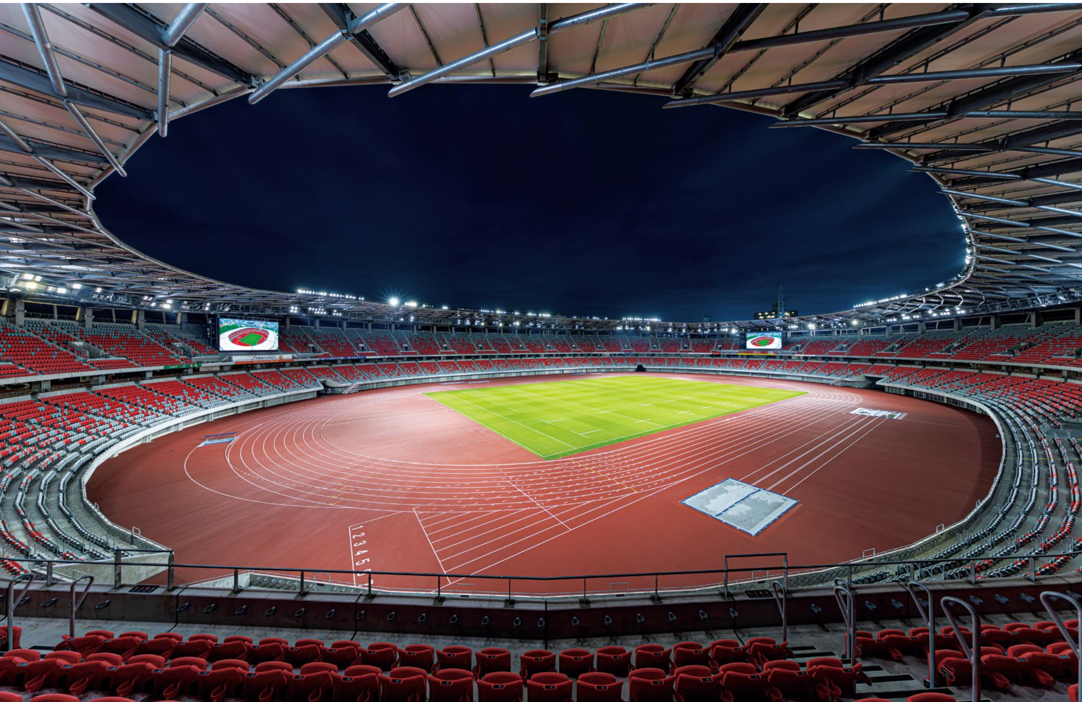
片持ち架構を用いた「膜屋根」では、632台の競技用照明がスタジアム内を照らす。 (陸上競技：アジア競技大会のパターン。4方向平均鉛直面照度2,000lx以上、地表面水平面平均照度2,000lx程度)
