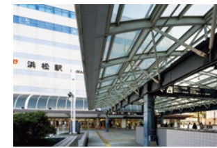
浜松まちなかライトアップ ■ライトアップ設備設置工事 所在地／静岡県浜松市中央区砂山町 施主／浜松市 企業寄付／株式会社電器堂 設備竣工／2025年11月
