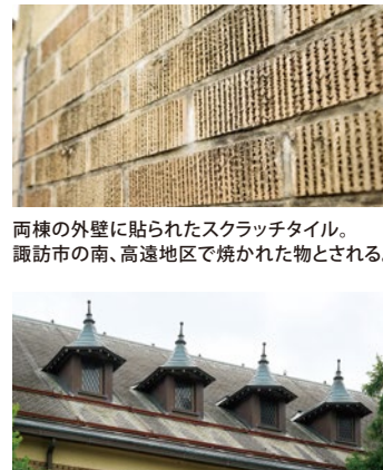
会館棟の屋根に並ぶドーマー窓。とんがり帽子を載せたような小屋根が特徴。
