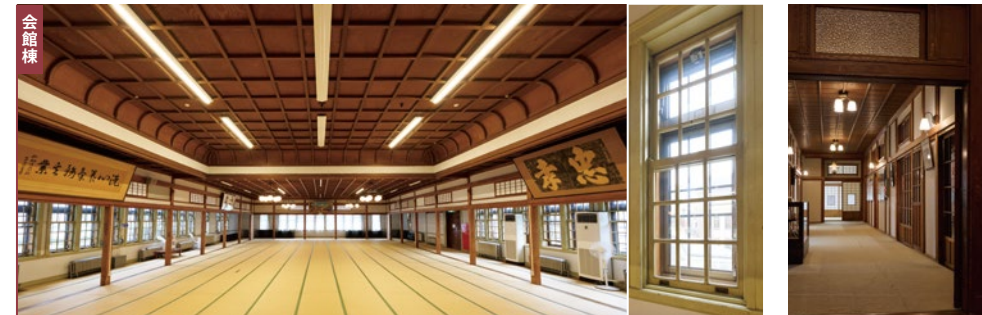
折上格天井をしつらえた204畳の大広間。当初は結婚式にも使用されていた。木造トラスの小屋根によって広い無柱空間を実現した。窓は外観が西洋風であることから上げ下げ窓（写真右）になっている。レトロな雰囲気照明や結霜ガラスが見られる廊下。守護や魔除けの意味がある熊の彫刻。塔内の螺旋階段。窓から諏訪湖が見える。
