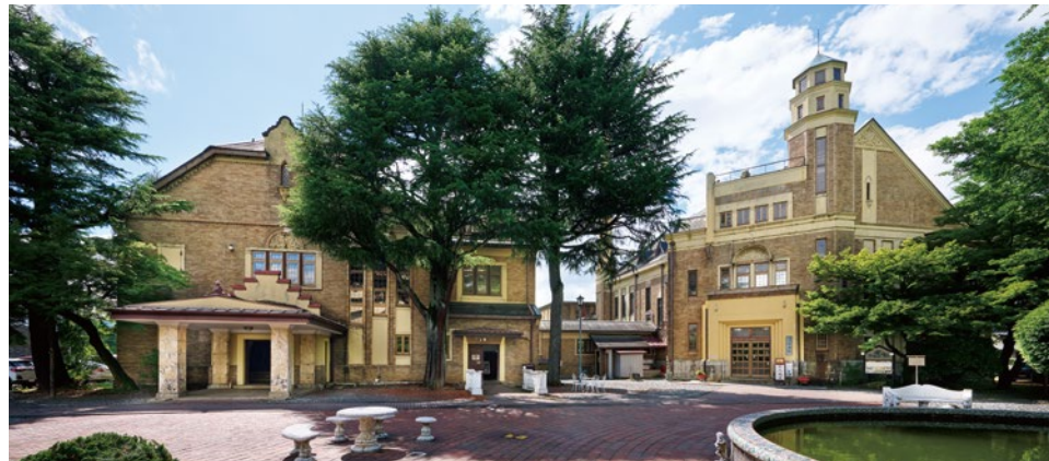
片倉館は諏訪湖畔に位置するため、約2,600本の松の木を基礎に杭打ちし、軟弱地盤を補強して建てられた。会館棟（左）は玄関上、浴場棟（右）は屋上にステップゲートル（階段状の破風飾り）を持つ。庭が広いのは散歩を重視する欧米スタイルによるもの。
