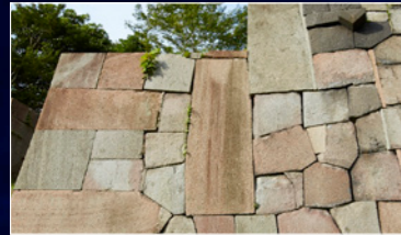
ピンクや緑の色味をもつ戸室石を 積んだ石垣(屋の様子)
