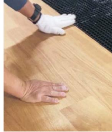
④ 専用塩ビシート 貼り付け
