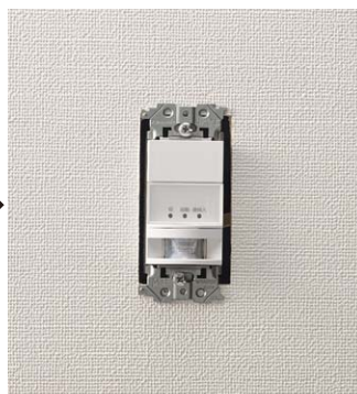
かってにスイッチを壁に取り付ける。
