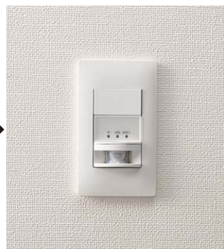
化粧プレートをはめて取り付け完了。
