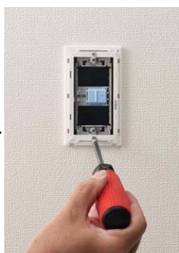
スイッチとプレート枠を壁に取り付ける。
