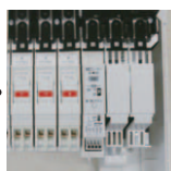
空きスペースに 感震ブレーカー を接続する。
