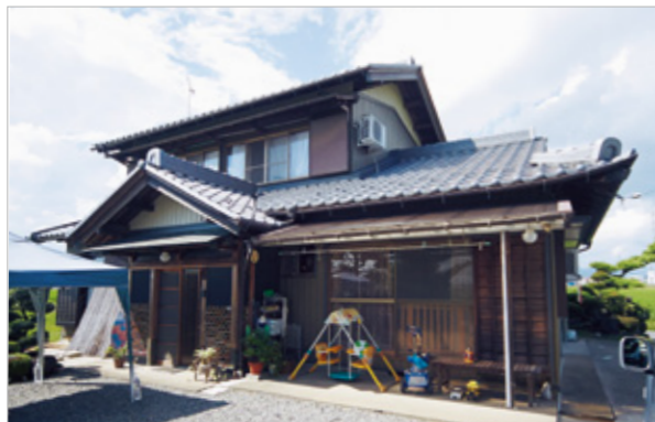
オール電化とスマートコスモを導入されたAさま邸外観。
