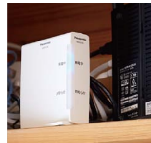
太陽光発電システムと同時にAISEGと計測ユニットを設置。
